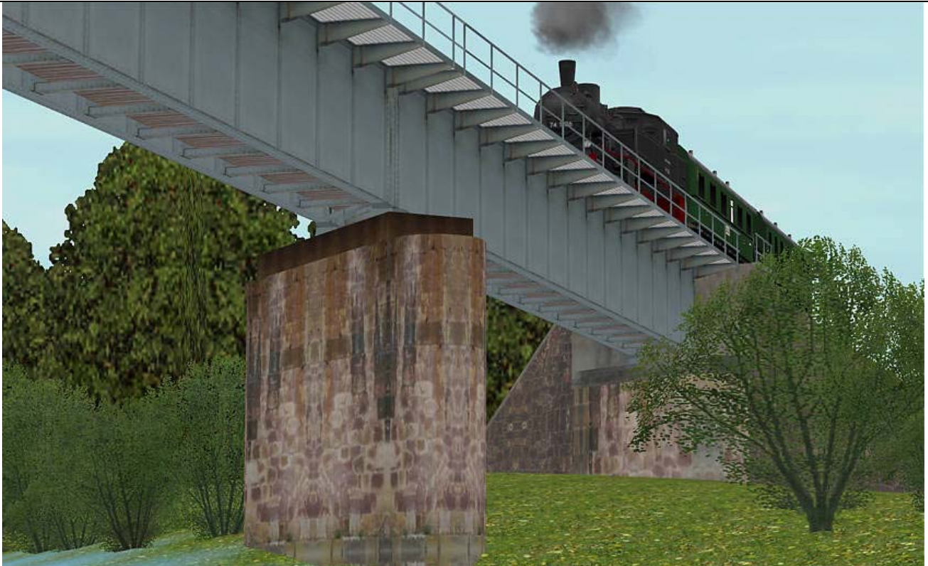
Blick aus dem Tal der Mulde hoch zur Brücke; Zug kommt aus Nossen.
