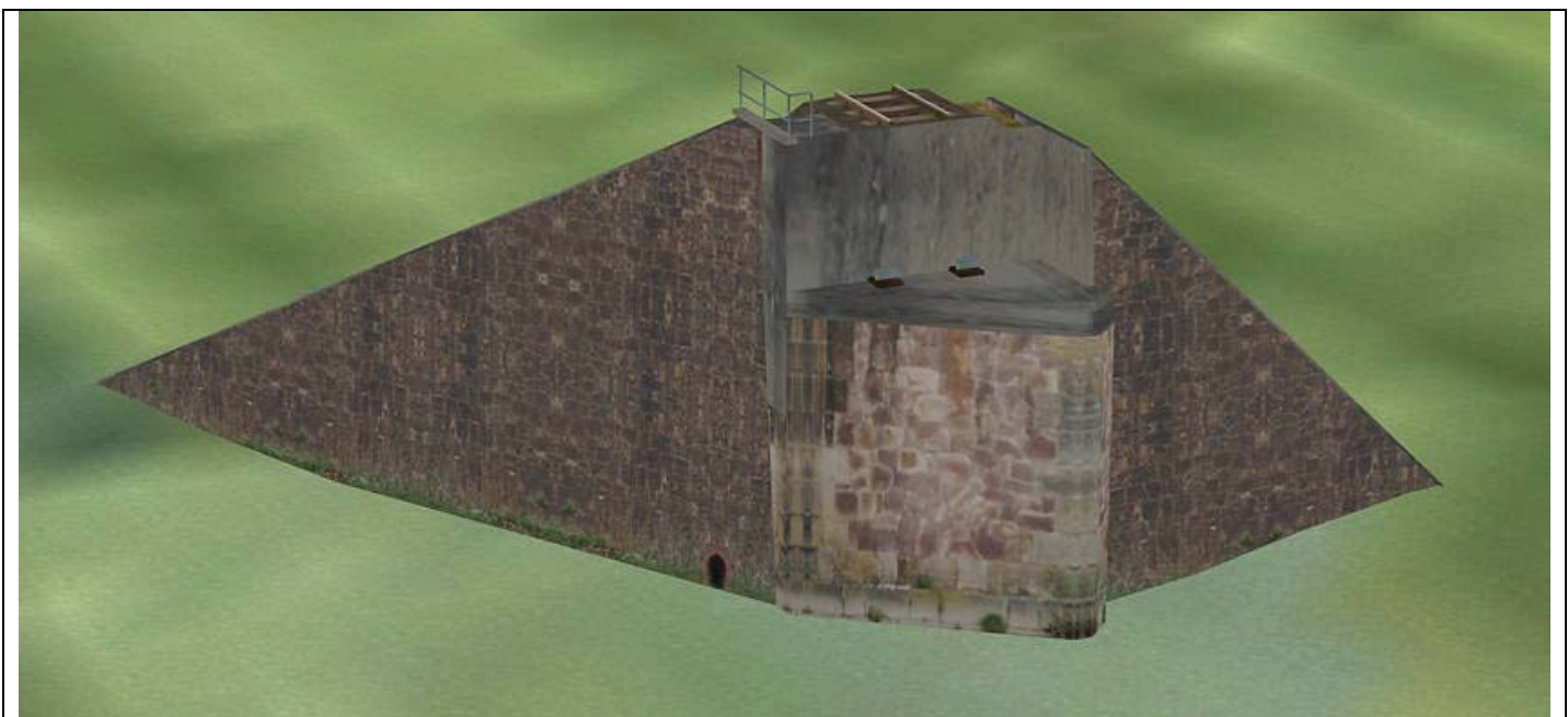
Gleisobjekt Nossen_Br1_01_AF: westl. BrKpf Brücke Altzella, Richtung Riesa; Stützmauern im Winkel von 30 ° (vorn) und 95° (hinten), Gleislänge 3 m
