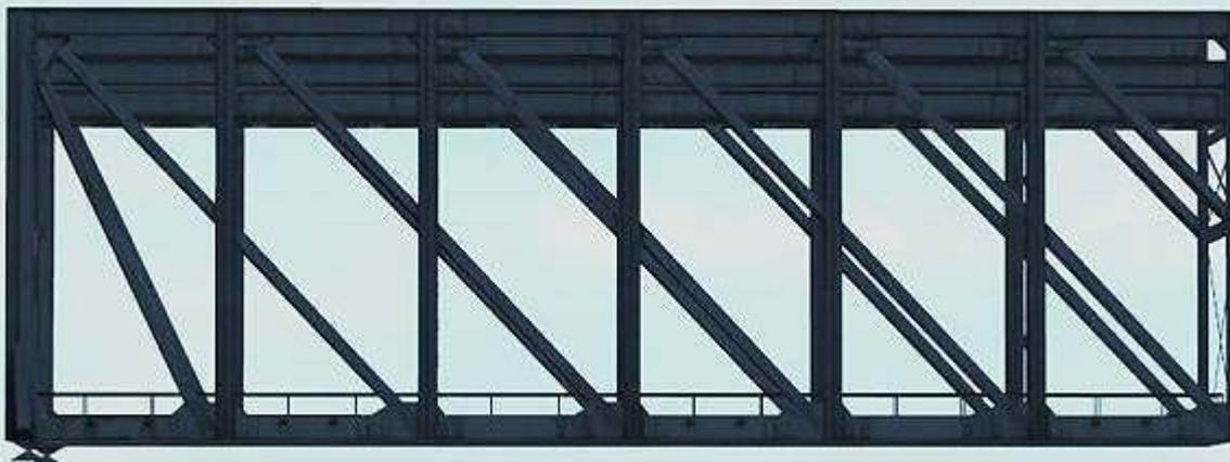
**Eglisau\_27\_AF1**, linkes Strom-Fachwerkelement, Länge 26,82 m, Gleislänge 25,82 m, SO max. 51,3 m; links von **Eglisau\_26\_AF1**, rechts nach **Eglisau\_17\_AF1**
