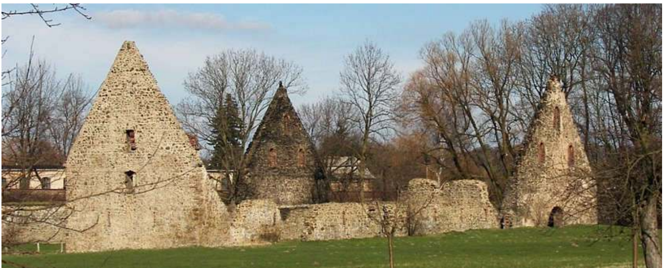
Die Ruine des Schüttgebäudes
