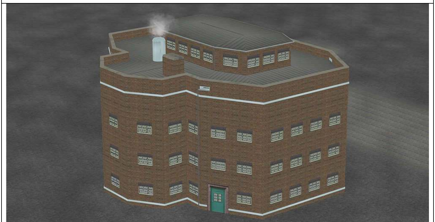
OK_V_Schaltwarte_AF1 , von Südosten; vor dem Schornstein ein Entrauchungsabzug
