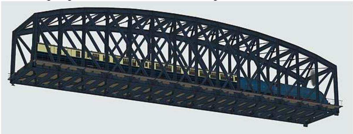
**Gleisobjekt Biehl\_2\_Fachwerk62m\_AF1**: **Zweigleisige Fachwerkbogenbrücke**; 62,52 m lang; Gleislänge 62,54 m zum Schaffen einer optischen Dehnfuge; unterschiedliche Auflager
