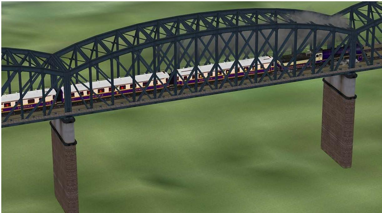
**Gleisobjekt Biehl\_2\_Fachwerk62m\_mP\_AF1: Zweigleisige Fachwerkbogenbrücke; 62,52 m lang; Gleislänge 62,54 m zum Schaffen einer optischen Dehnfuge; unterschiedliche Auflager; einseitig angesetzter Pfeiler, der eine leichte Durchfahrhöhe von 22,70 m schafft.**
