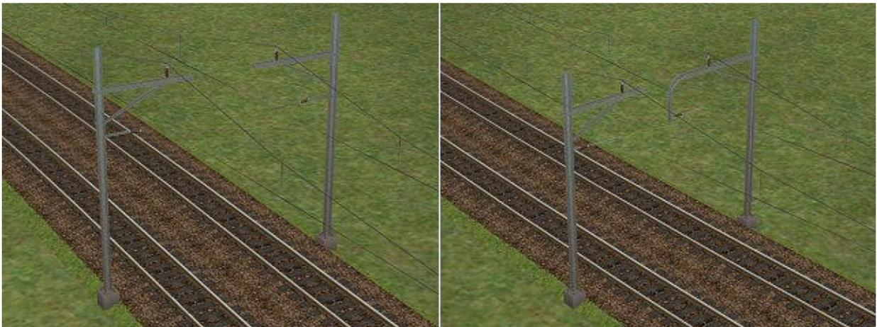
Abb. Mastpaare der SBB zur gleichzeitigen Bestückung von 2 Gleisen.
