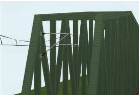
Halterung für die Oberleitung bei eingleisigen Brücken
