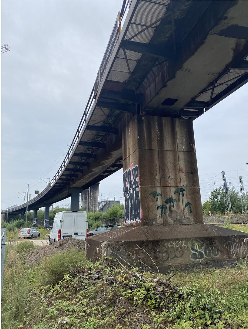
Westlicher Teil der Brücke mit dem altona-seitigen Brückenkopf, vier Stahlstützen und einer Betonstütze.
