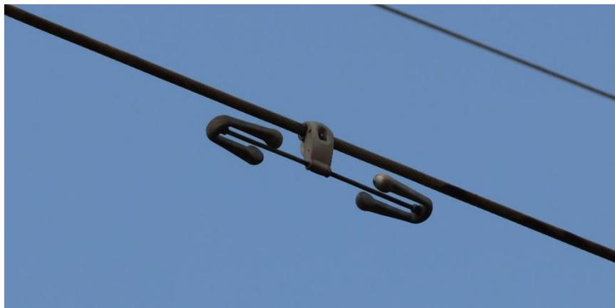
**Schwingungsdämpfer an einem einfachen Leiterseil**
