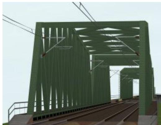
Halterung für die Oberleitung bei zweigleisigen Brücken
