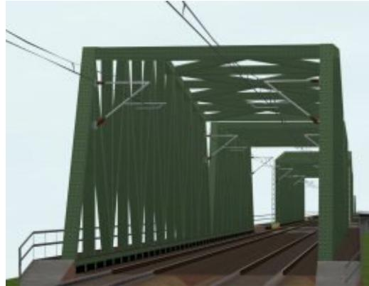
Halterung für die Oberleitung bei zweigleisigen Brücken
