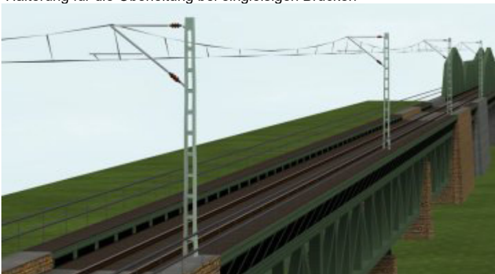
Brückenmasten für die Oberleitung
