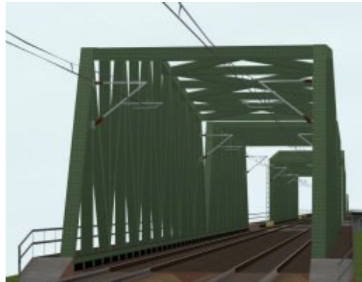
Halterung für die Oberleitung bei zweigleisigen Brücken
