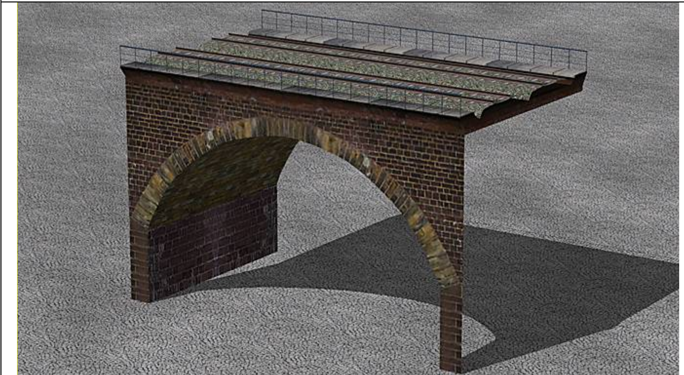
Gleisobjekt Biehl_2_Bogen_G_AF1: 2gl Gewölbe mit gelbem Gewölbebogen, Gleislänge 20 m, Lichte mittige Durchfahrtshöhe 10 m. Eingerichtet für Gleisstile mit Schotterbett.
